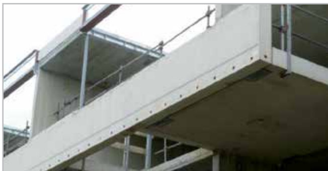
BEVESTIGING VAN BALKON BALUSTRADES
