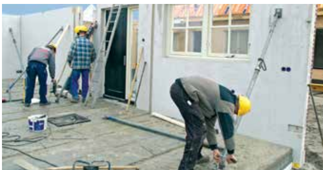
STELLEN EN BEVESTIGEN VAN PREFAB WANDELEMENTEN
