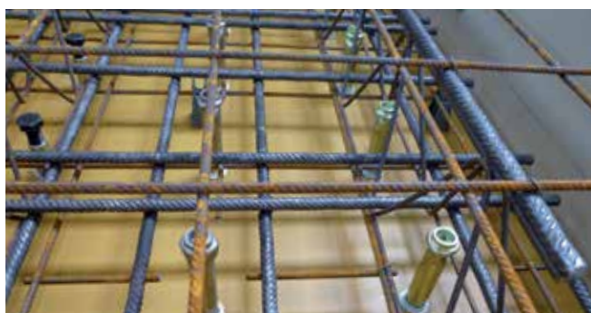
MONTAGE VAN BEVESTIGINGSANKERS
