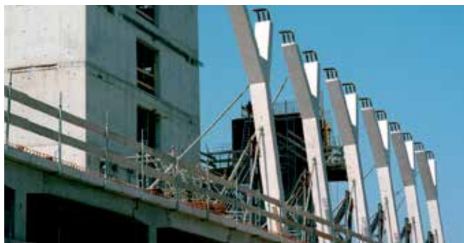
STELLEN EN BEVESTIGEN VAN PREFAB ELEMENTEN
