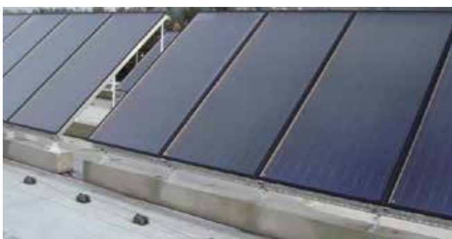
BEVESTIGING VAN ZONNEPANELEN
